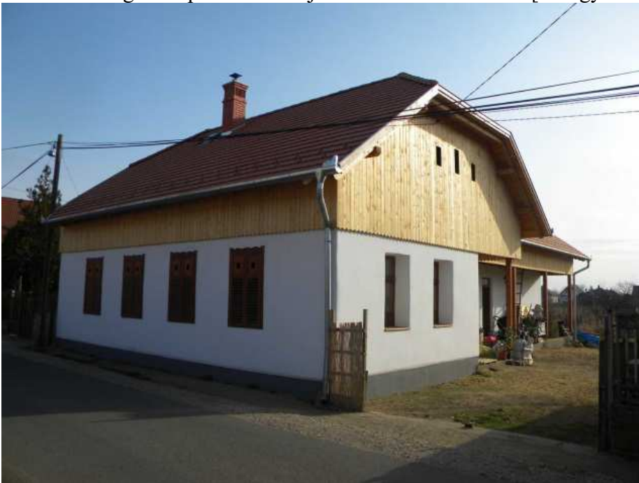
5. ábra A megvalósult épület előtérben a meglévő utcai épületrésszel [Foto: Márton Révész]
