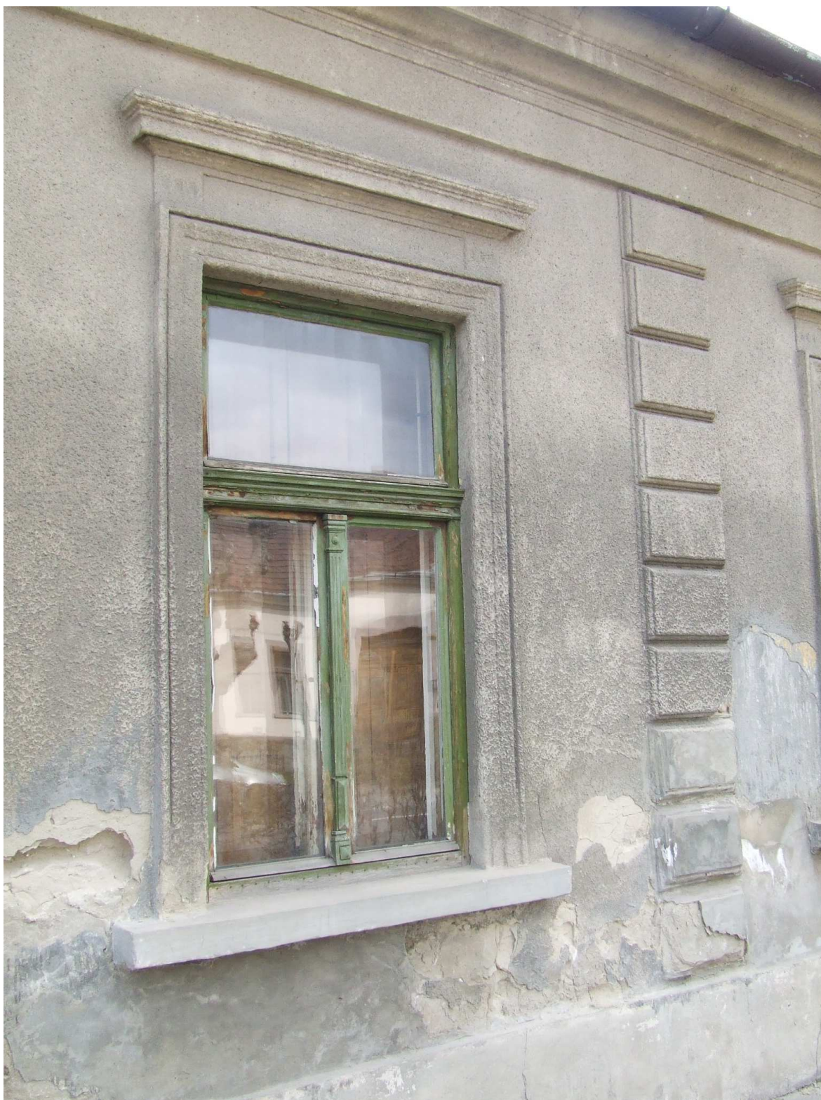
1-1. ábra: Az épület utcai homlokzatának részlete a felújítás előtt.
