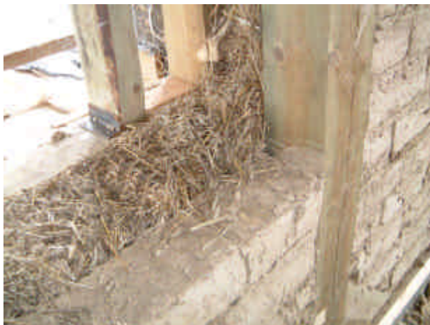
5.kép: Galgagévíz - szalmás-vályogfal
